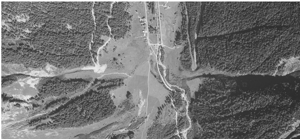
Photo 8. Photo aérienne du 07.09.1988. Route forestière du Ban de la Berte en cours de construction, ainsi que de la digue de guidage (swisstopo).
